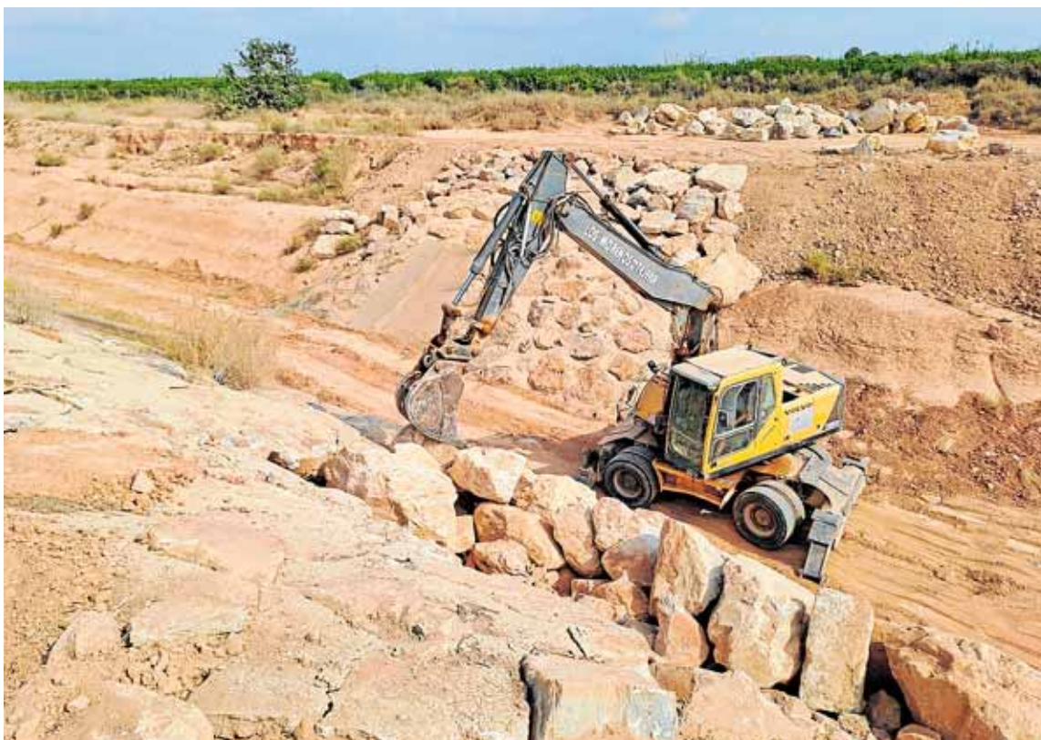
Una excavadora levanta una pared de escollera en el último tramo del cauce de la rambla. CHS
