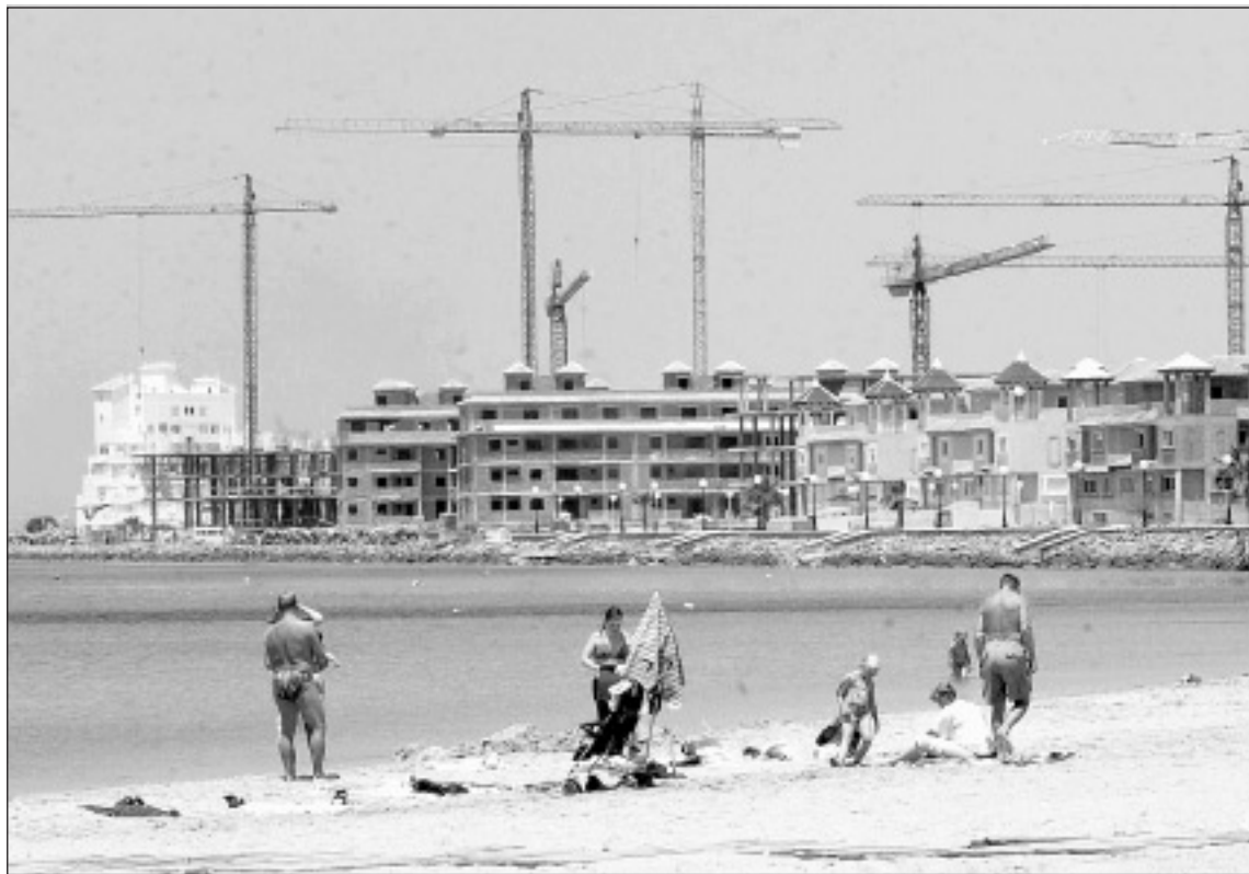
Varios edificios en construcción en una zona costera.
