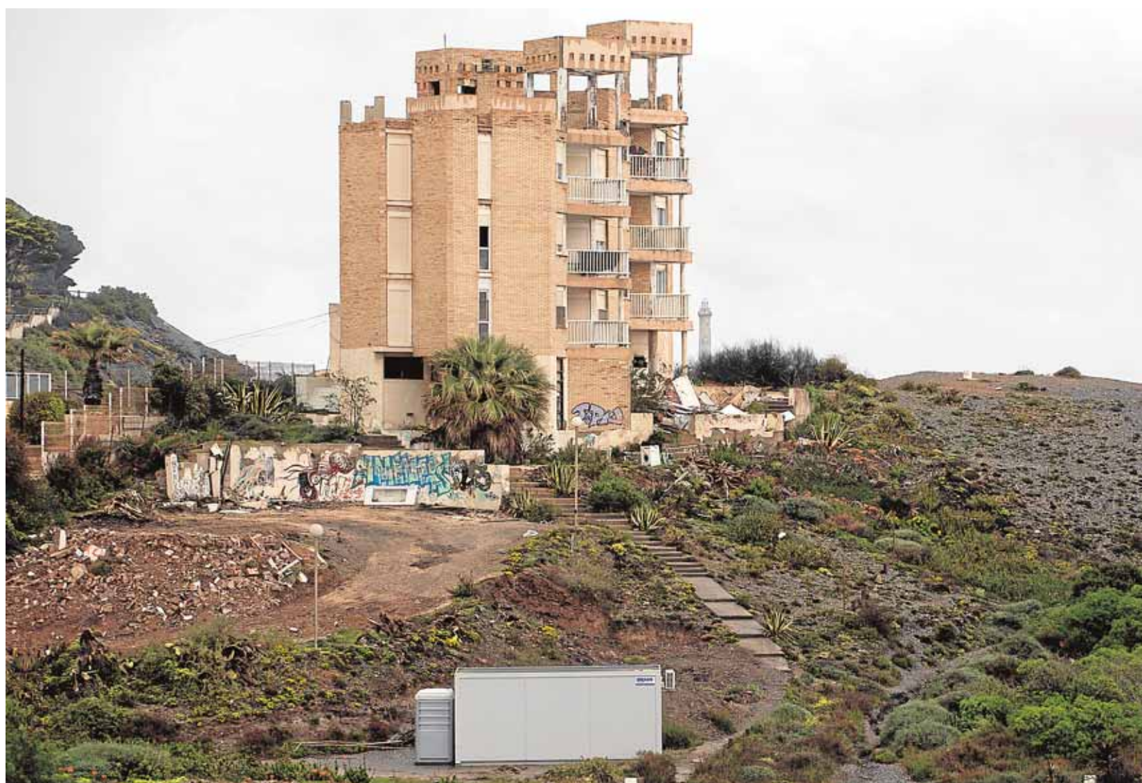
Edificio ubicado en Cala del Descargador, en Cala Flores, junto a una montaña de escombros formada tras el derribo de un pequeño inmueble anexo al
