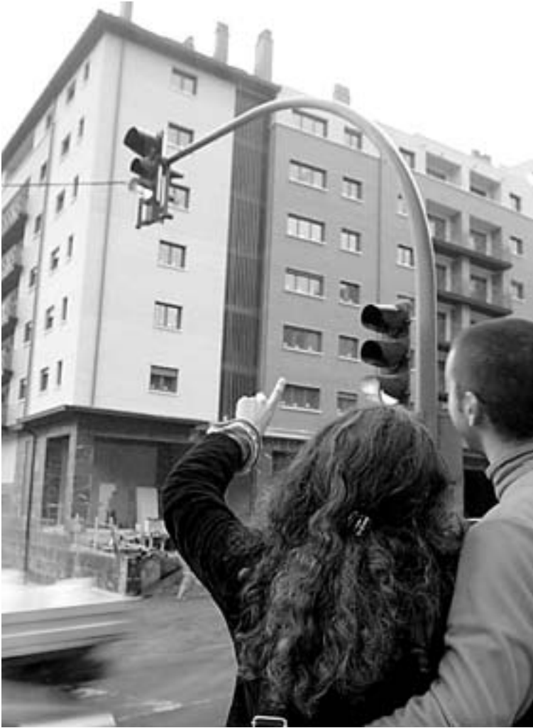
INCÓGNITA. Una pareja contempla un bloque de pisos recién terminados con la intención de trasladarse a vivir allí. / E. C.
