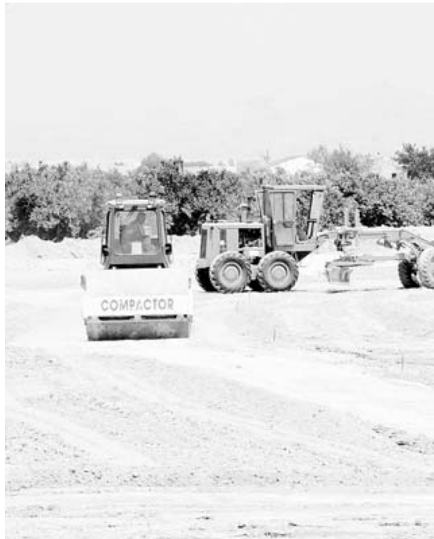
MOVIMIENTO DE TIERRA. Los ingenieros han acotado el terreno y la
