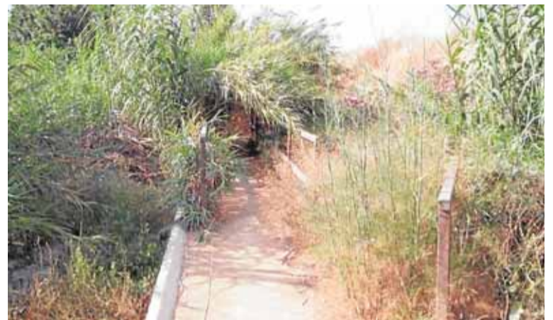
Estado de abandono de uno de los tramos del corredor. :: HUERMUR
