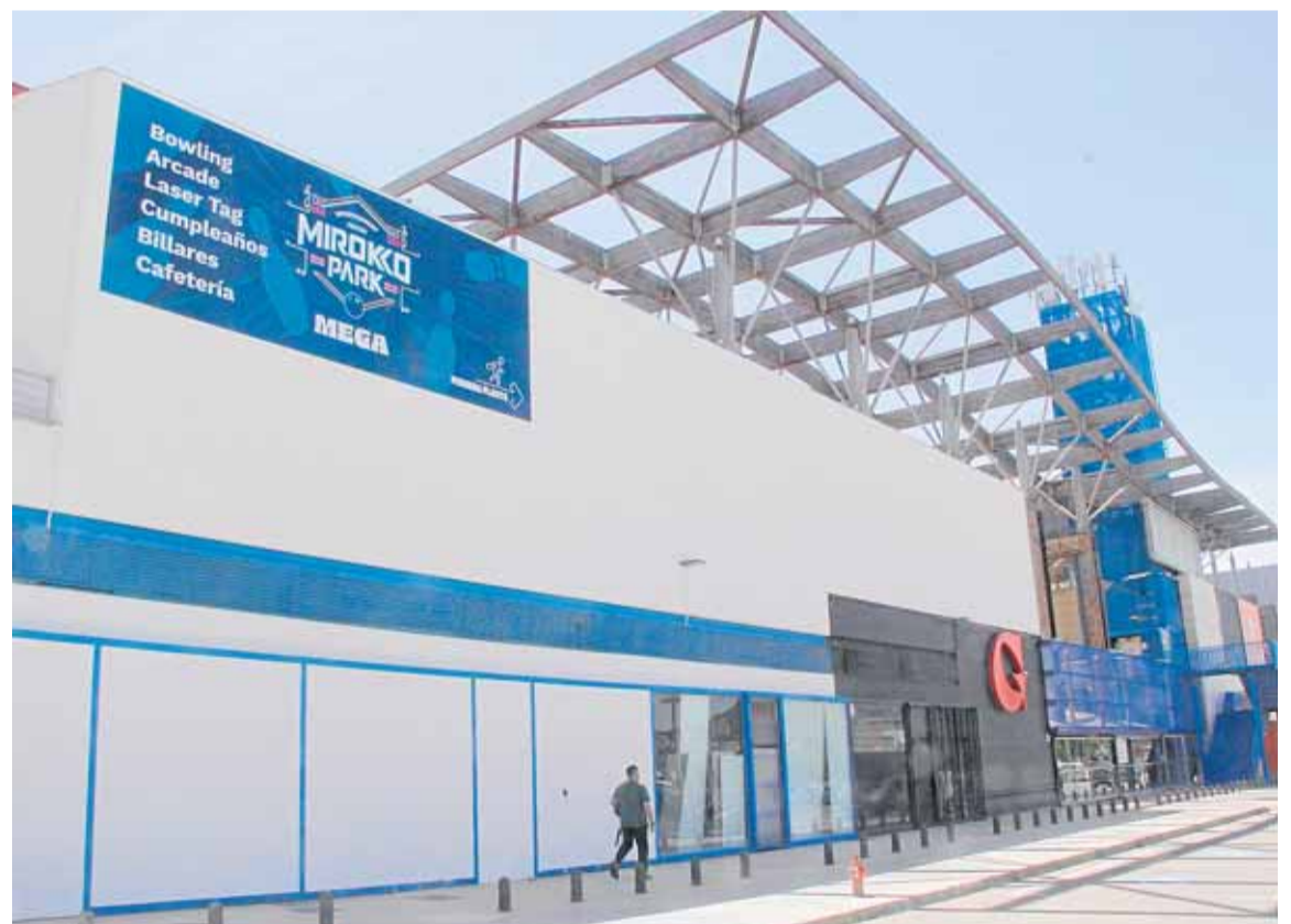
Los operarios ultimán los preparativos para abrir el centro de ocio en el centro Mandarache. PEDRO MARTÍNEZ / AGM
