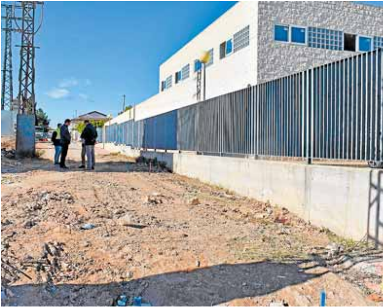
Visita a las obras para la futura extensión de la calle Barcelona. AYTO.
