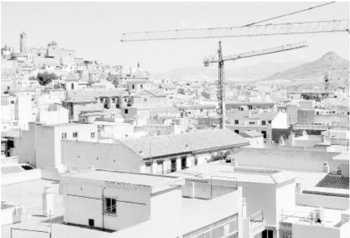
OTRAS ESPADAÑAS. Las grúas sobre los tejados compiten con las iglesias. / PACO ALONSO / AGM
