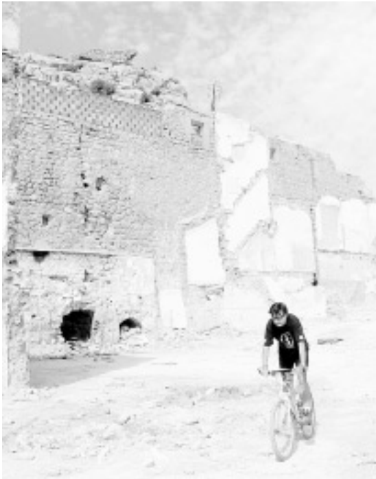
MURALLA. Tramo en calle Rambla. / P.A. / AGM
