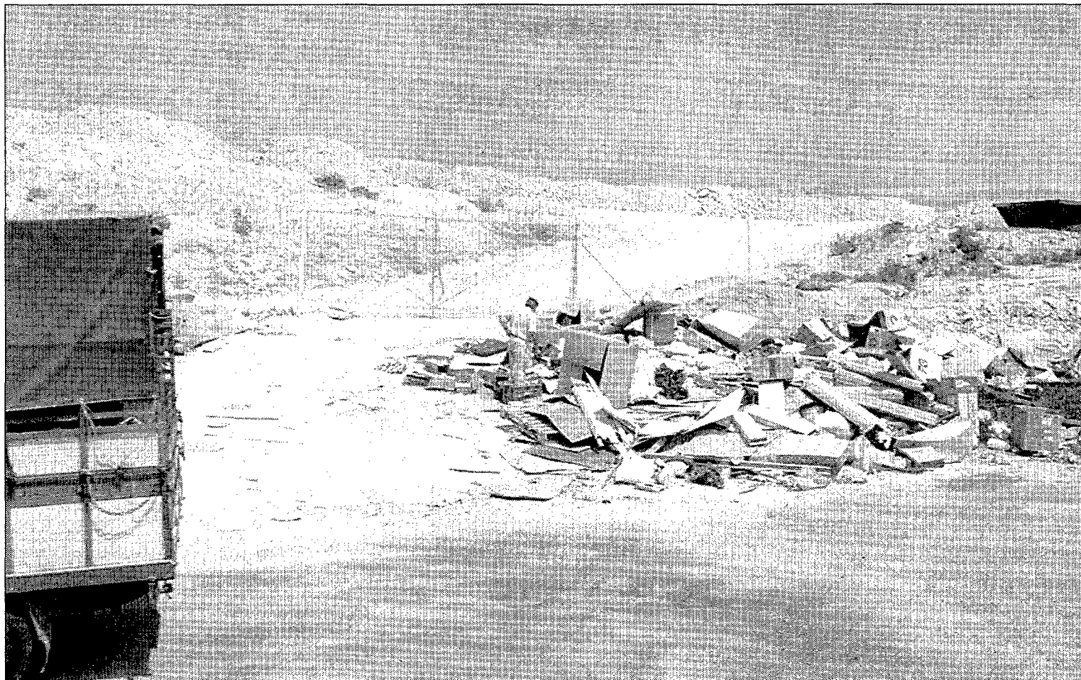
Restos de materiales de construcción en una de las entradas de la antigua escombrera de Molina de Segura.
