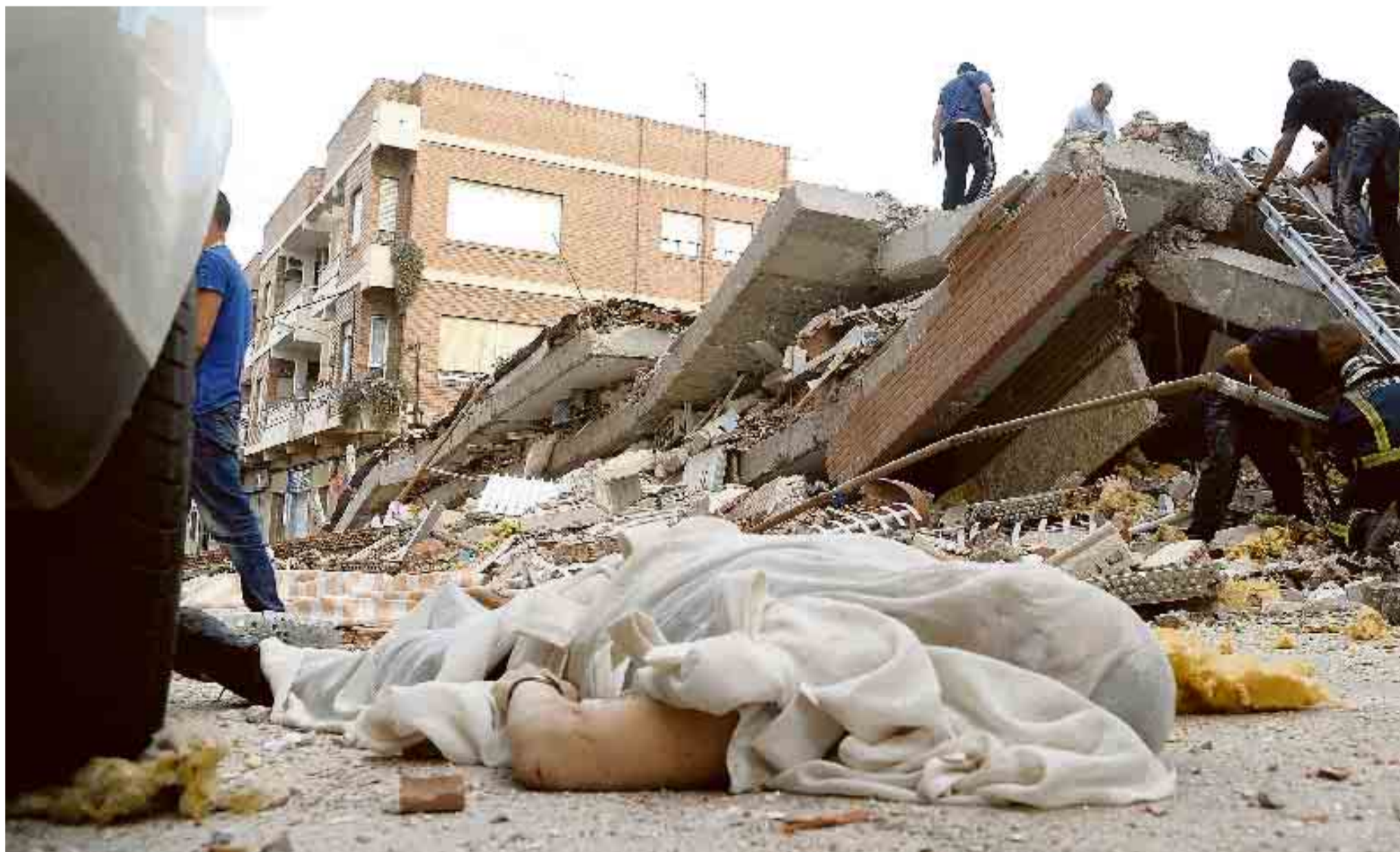
El cuerpo de una mujer cubierto con una cortina, en medio de la calle Infante Juan Manuel, junto al edificio derruido que le causó la muerte. :: NACHO
