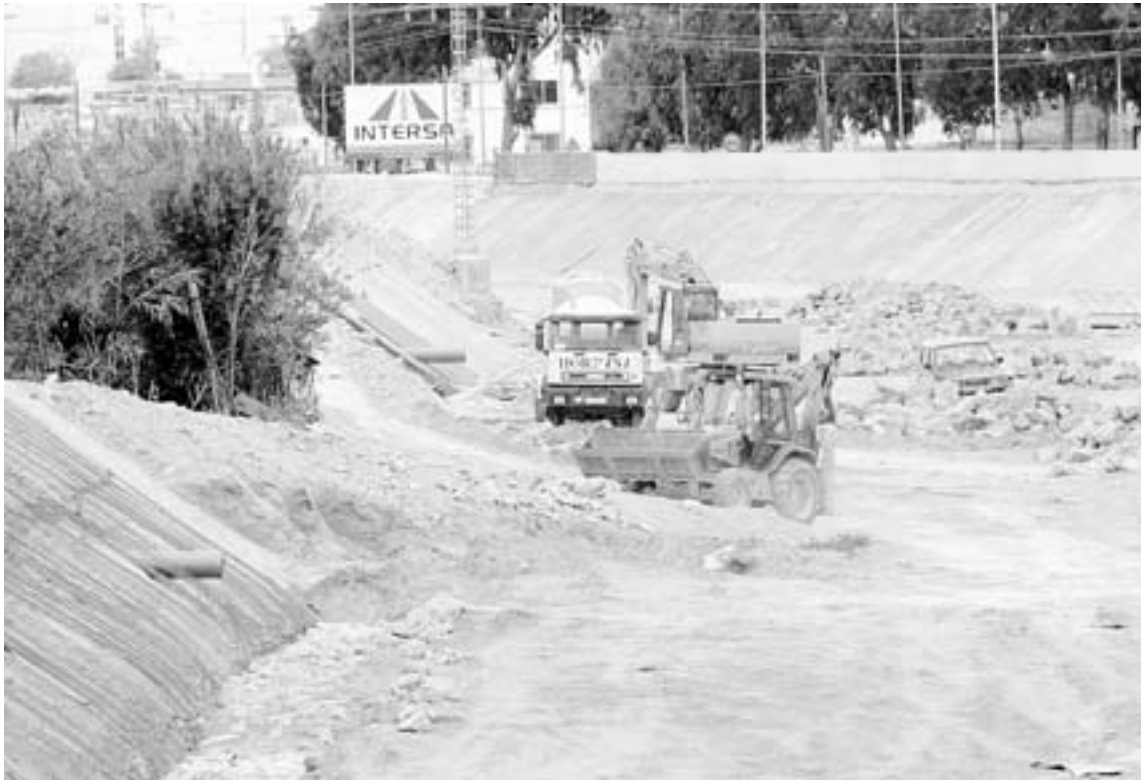
PAREDES. La maquinaria trabajando sobre el cauce con las paredes ya formadas. / J. M. RODRÍGUEZ / AGM
