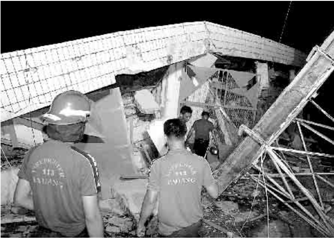
BÚSQUEDA. Equipos de rescate buscan víctimas en un edificio derrumbado. / EFE
