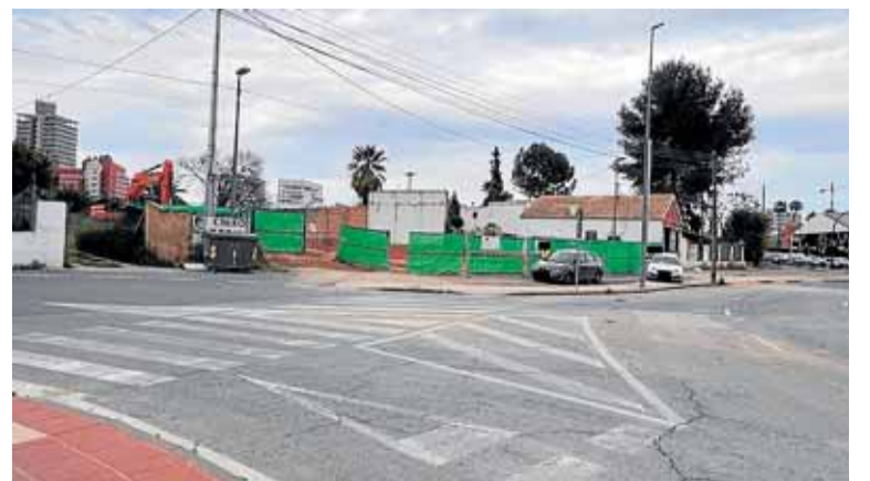
Parcela en obras para la nueva gasolinera. A. V. SENDA DE GRANADA OESTE
