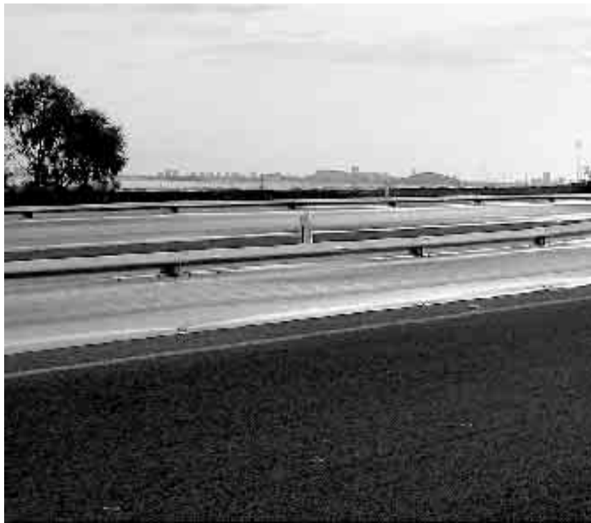
DE MALLA. Imagen del sistema protector instalado en los guardarraíles
