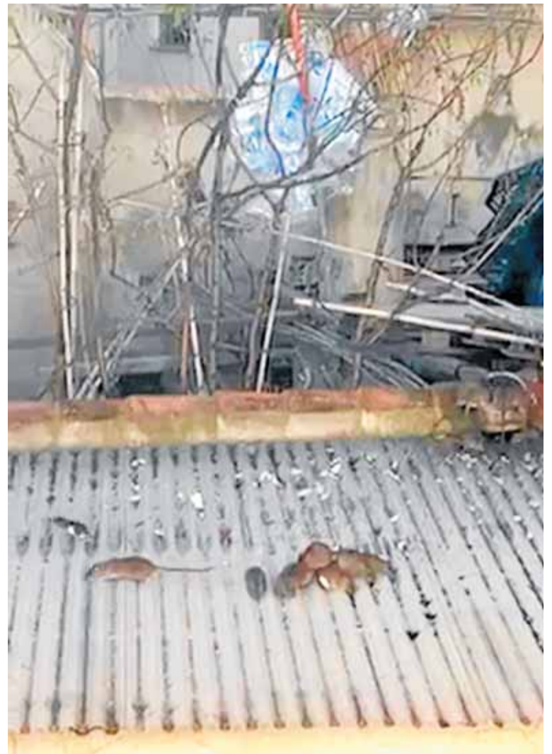
Varios roedores, en el techo de la vivienda de la calle Picasso. LV
