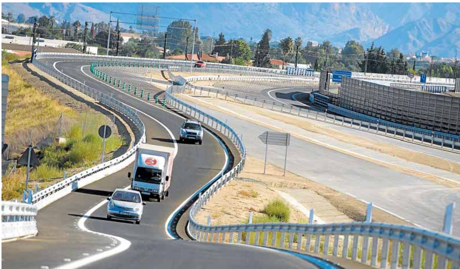
Ramal provisional de conexión de la autovía Zeneta-San Javier con el vial del Reguerón. A la derecha, la parte pendiente hasta Santomera. N. GARCÍA
