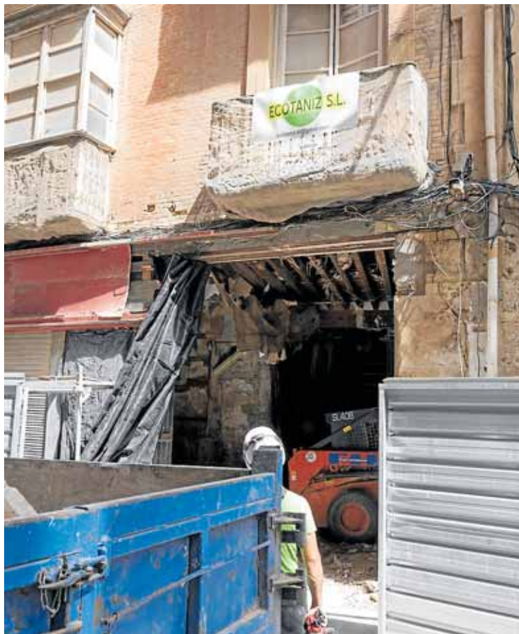
Trabajos de demolición del interior del edificio, ayer. ANTONIO GIL / AGM
