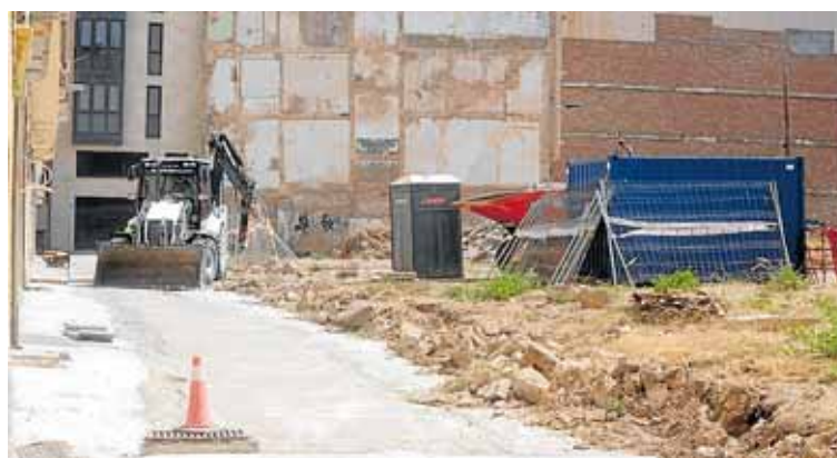
Trabajadores de Jumabeda, ayer, en la calle Cantererías. ANTONIO GIL / AGM
