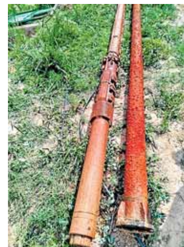
Dos tuberías desmanteladas. CHS
