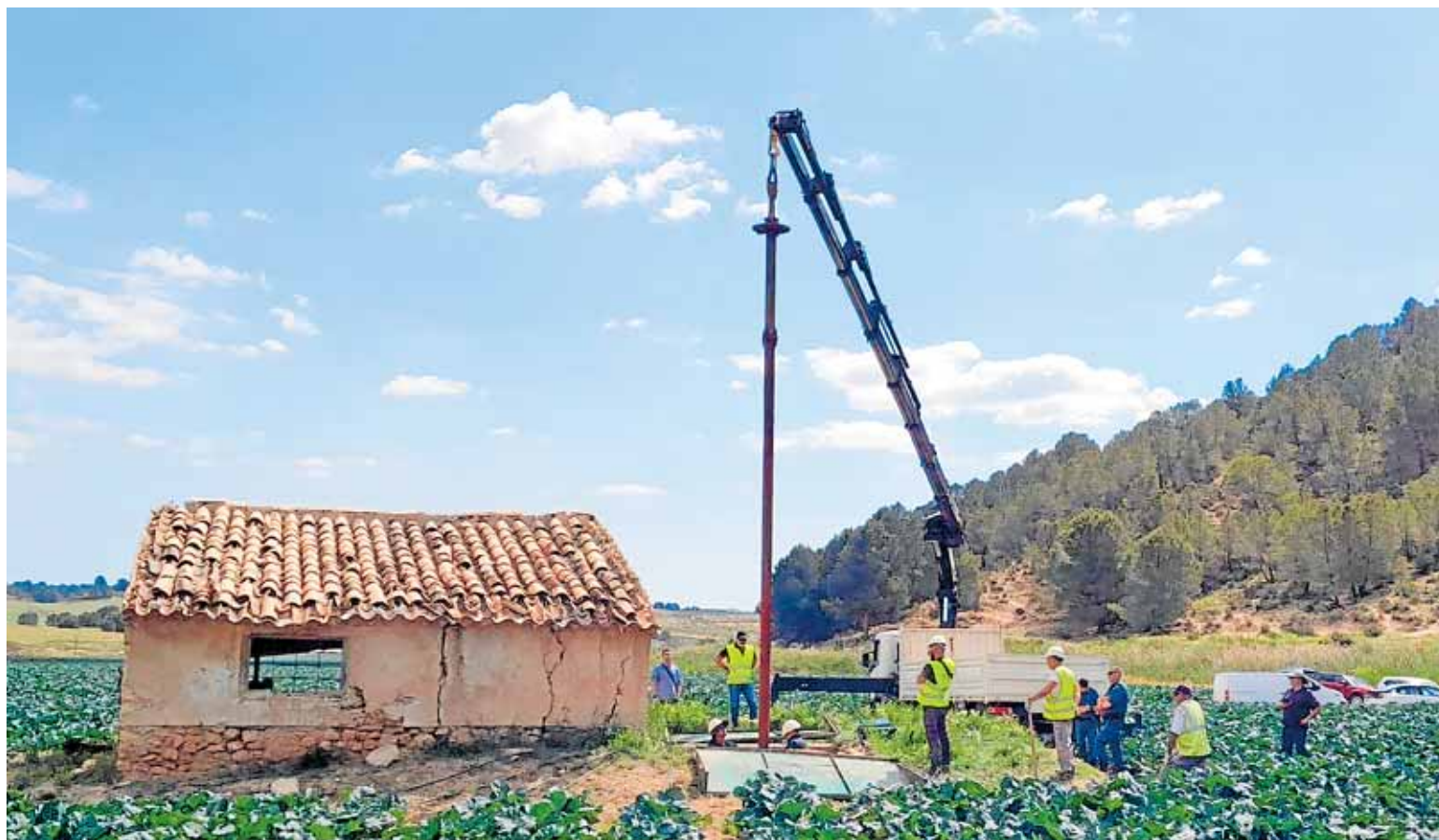
Un grupo de operarios, durante la clausura del pozo en la Cañada de Tarragoya, en una finca de brócoli y cerca de una zona forestal. CHS
