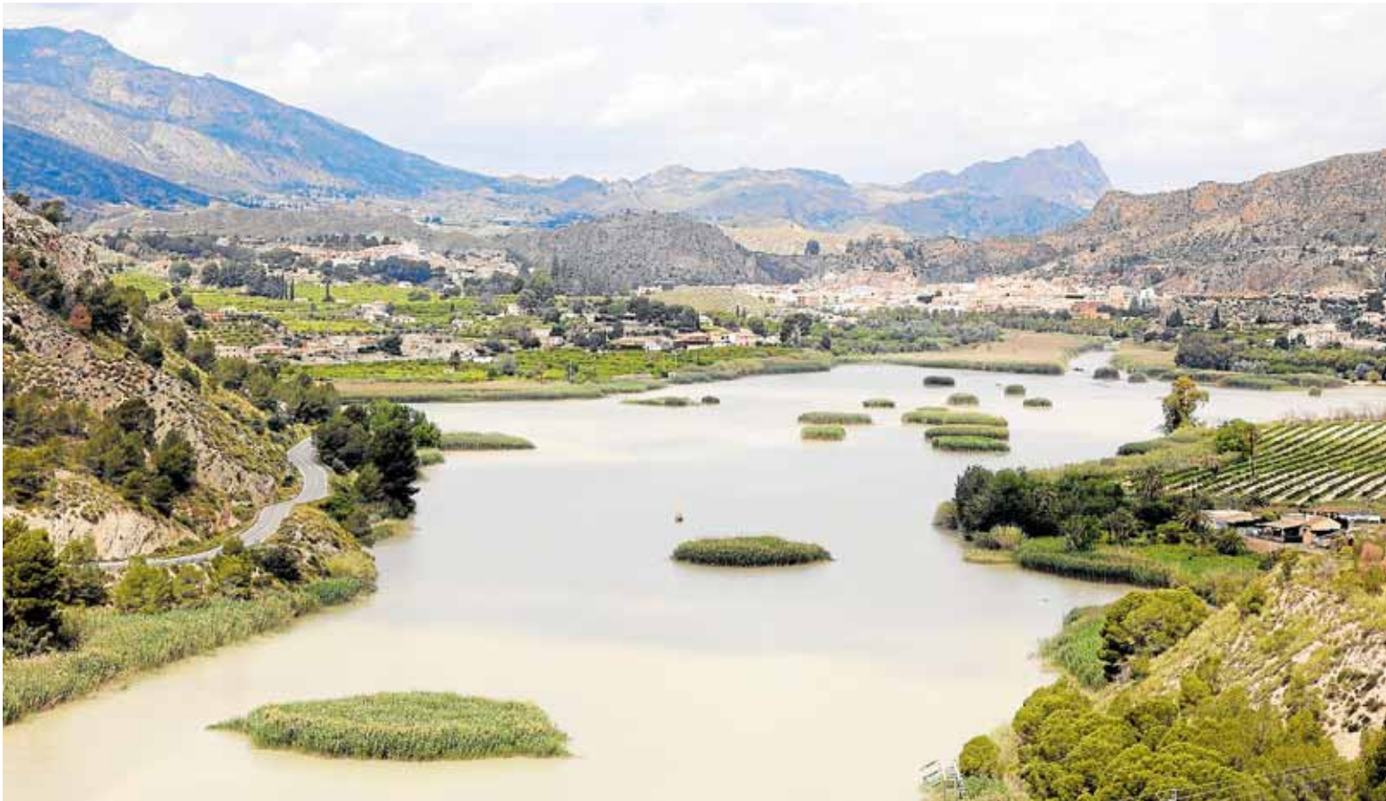
Embalse del Azud de Ojós, donde llegan las aguas propias del Segura y las aportaciones del Tajo. NACHO GARCÍA
