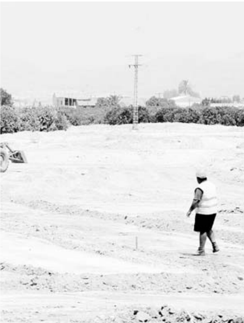
excavadora ya se encargaba ayer en Alquerías de mover la tierra. / J. LEAL
