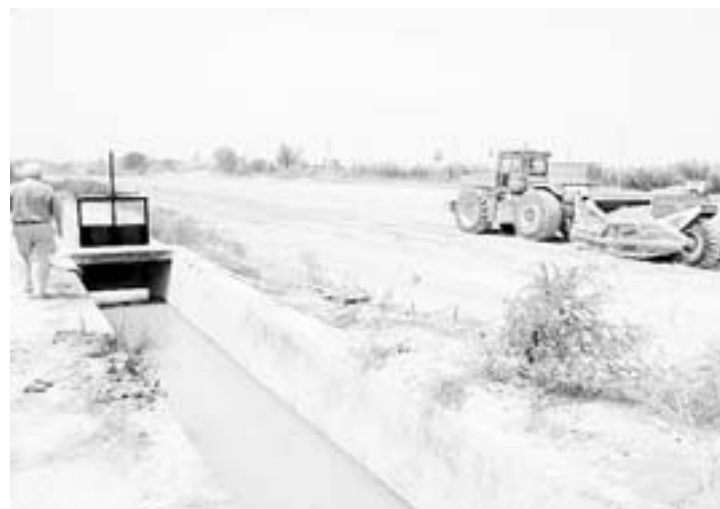
ACEQUIA. Un huertano pasea por la orilla de la acequia, mientras las máquinas desbrozan los terrenos para el AVE. / J. L
