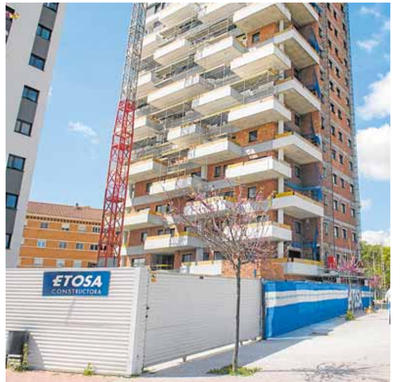
Obras del Residencial Metrópolis, en Juan Carlos I. ROS CAVAL / AGM
