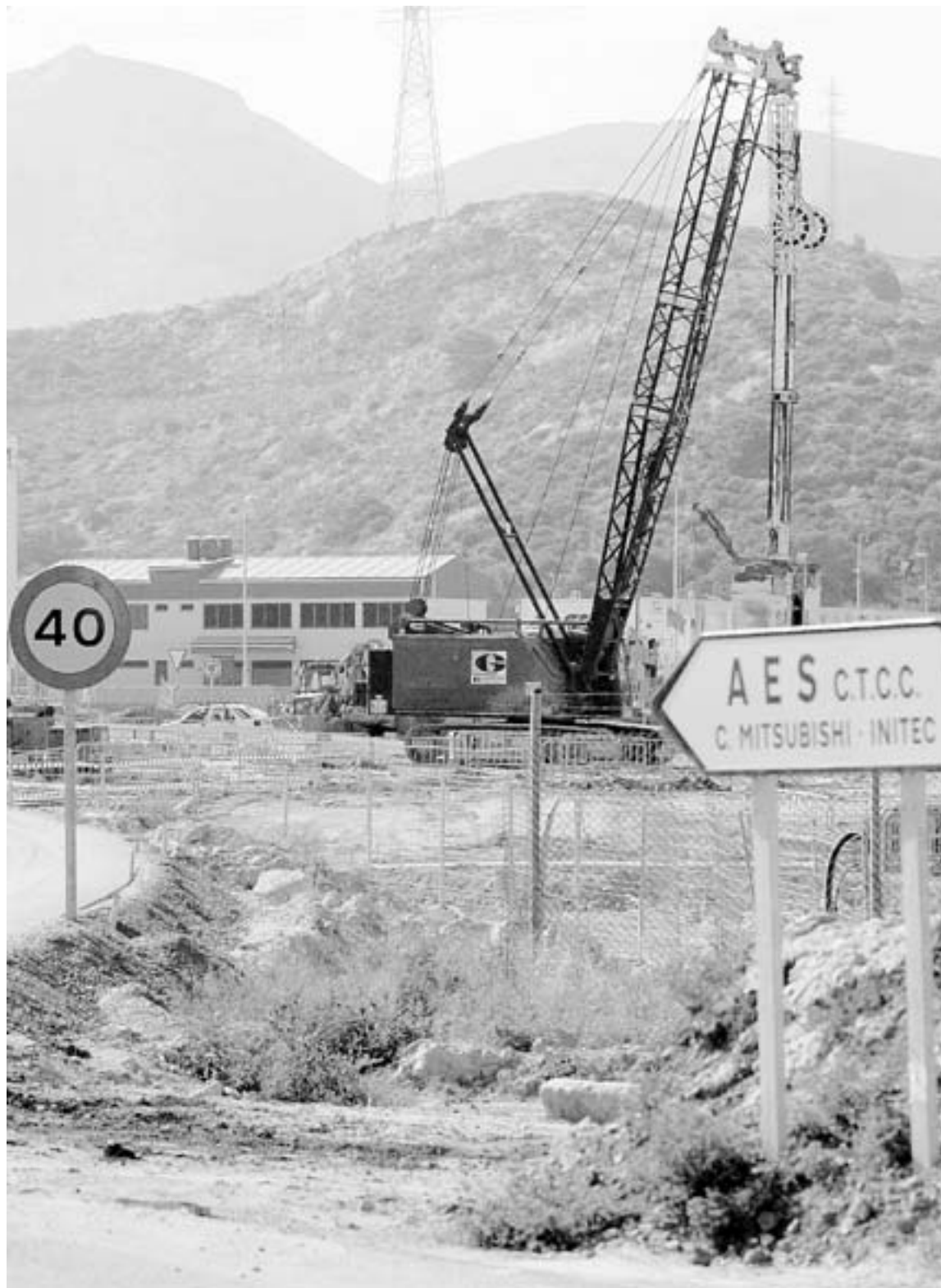
EN CONSTRUCCIÓN. Obras que se ejecutan en El Fangal para levantar la planta de AES. / J. M. R. / AGM
