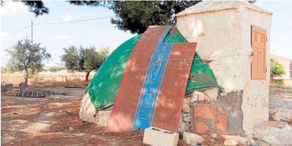
Unos ladrillos tapan el agujero donde estaba alojada la pila de lavar ropa en este aljibe centenario, en un paraje rural de Totana; los vecinos consiguieron recuperar la pieza, que ahora está guardada en una nave. LA VERDAD
