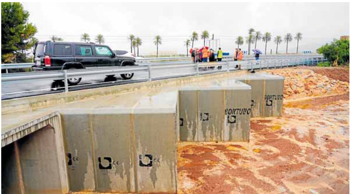
La zona de la rambla de la Carrasquilla, tras las obras de refuerzo de la seguridad realizadas en mayo de 2021. AC
