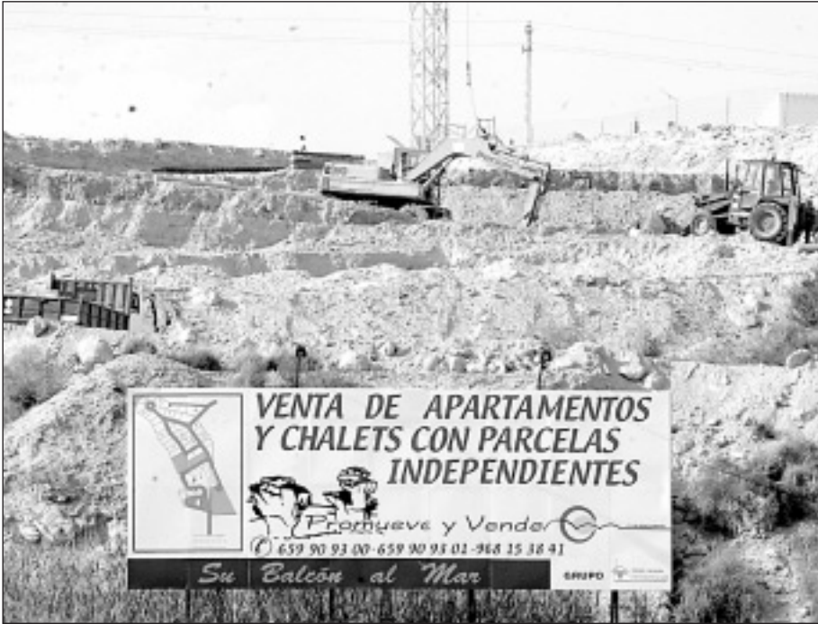
Las máquinas trabajan en una urbanización en construcción en Bolnuevo (Mazarrón).
