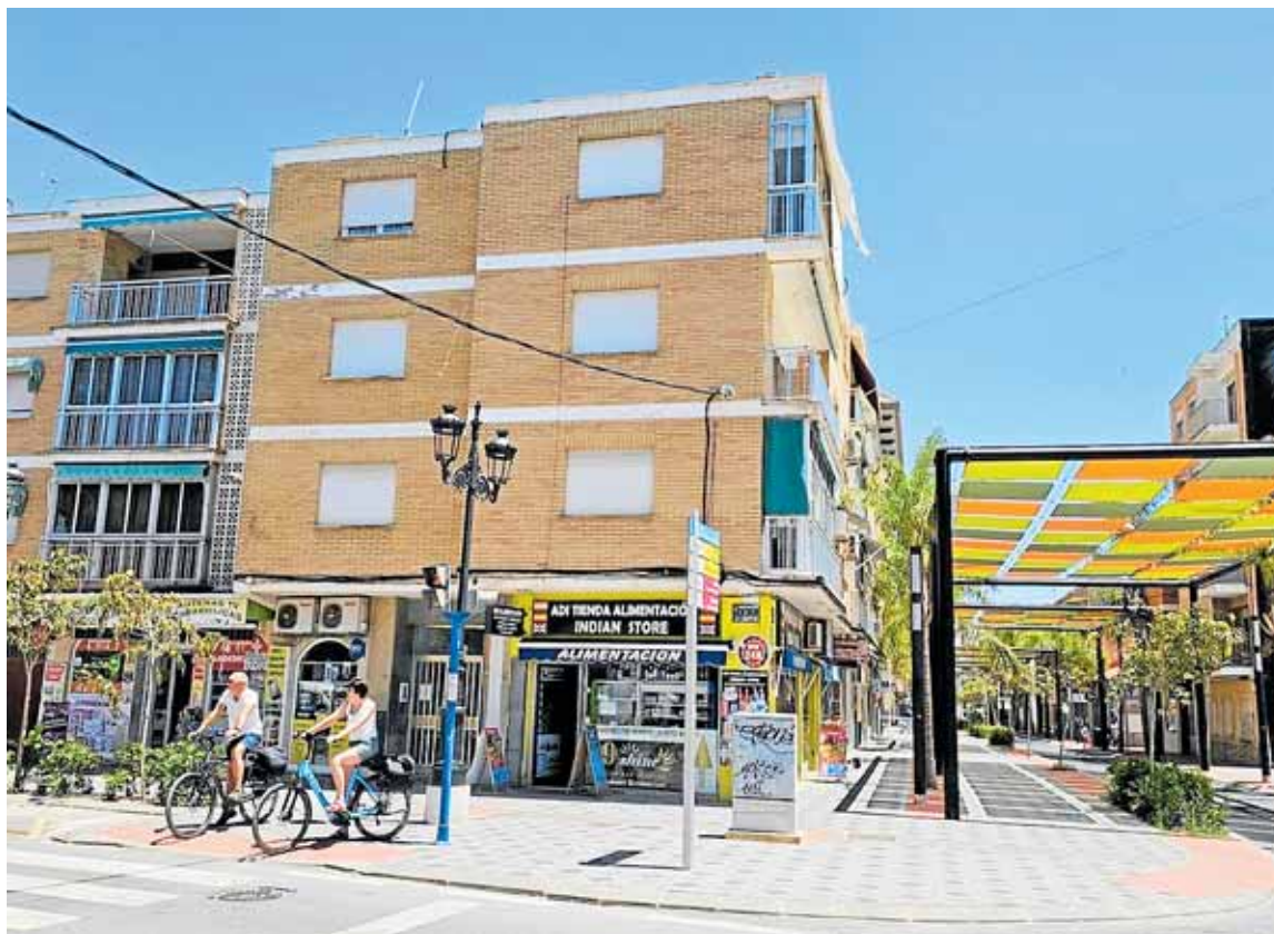
Dos ciclistas, ayer, delante del edificio Alcázar, entre las avenidas de la Libertad y 13 de Octubre. A. SALAS
