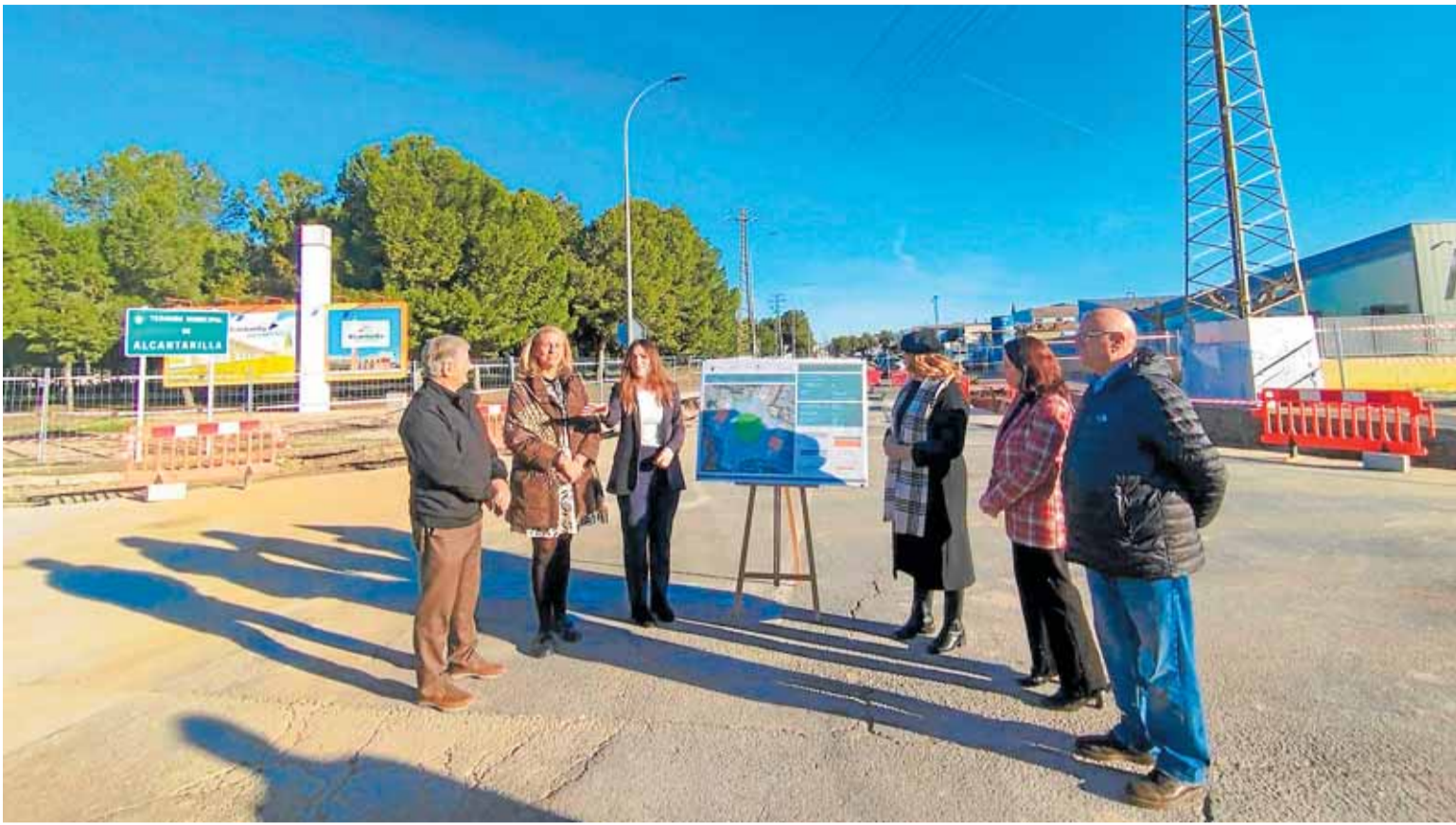
Las autoridades locales de Murcia y Alcantarilla, ayer junto a las obras de la glorieta. GUILLERMO CARRIÓN / AGM
