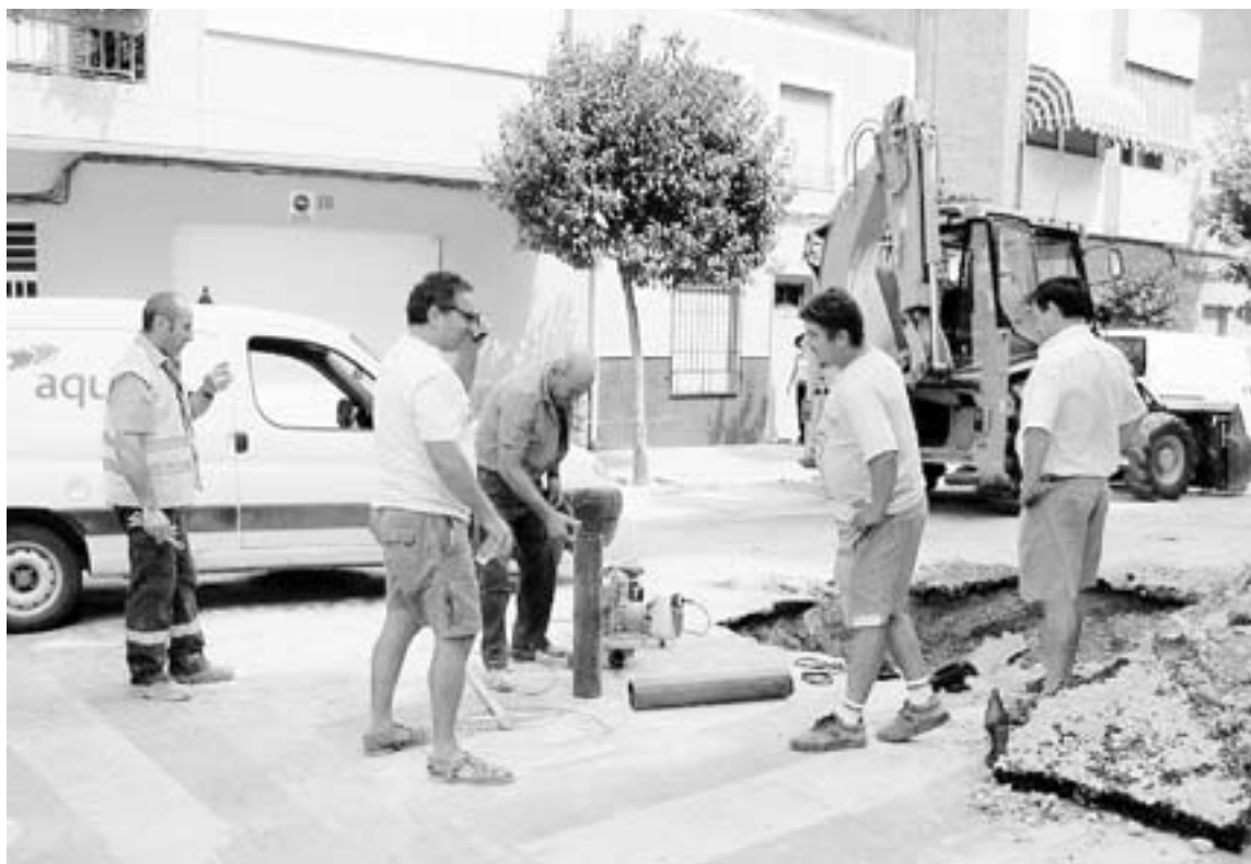
A MARCHAS FORZADAS. Los técnicos de Aqualia reparan la avería en la calle Esteban Díaz. /c.o.
