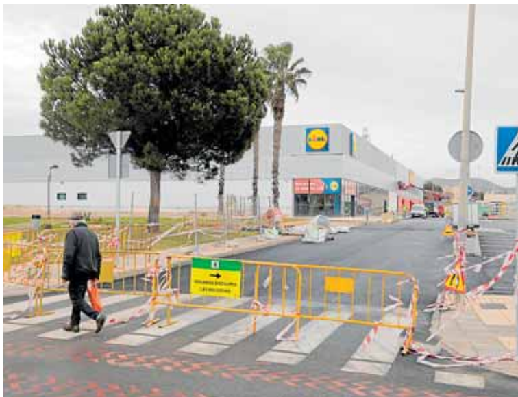
Obras para la apertura de un Lidl en Mandarache. PEDRO MARTÍNEZ / AGM
