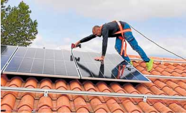
Un operario instala un panel solar en el tejado de un inmueble. AYTO.
