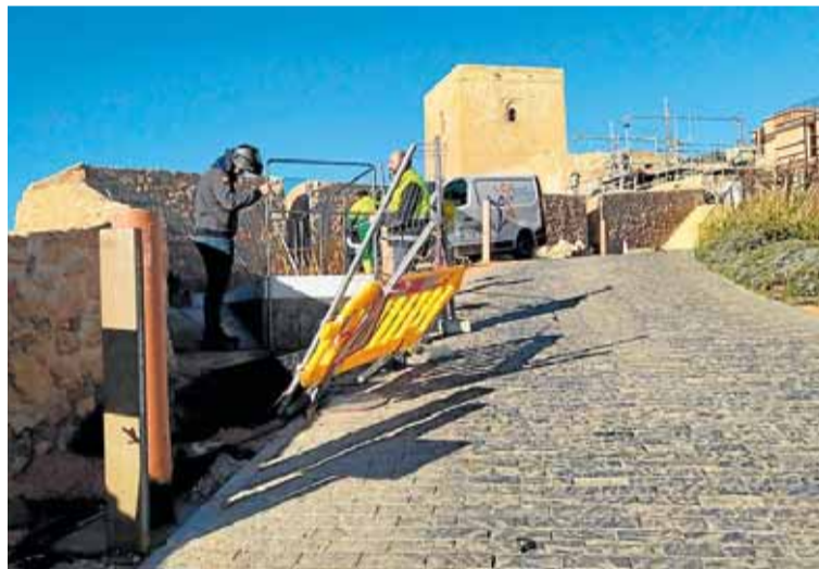
Obras de restauración de la muralla afectada por las humedades. I. RUIZ
