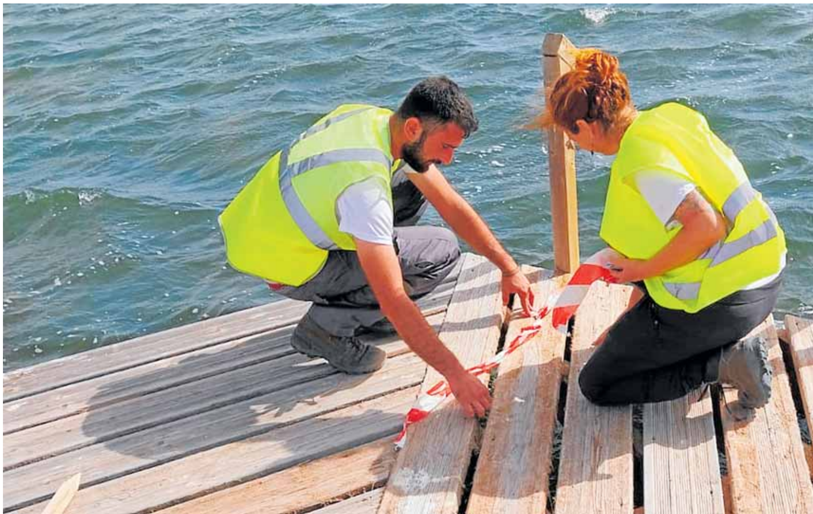
Dos operarios inspeccionan uno de los balnearios que serán reparados por la Comunidad Autónoma en el litoral sur del Mar Menor. CARM
