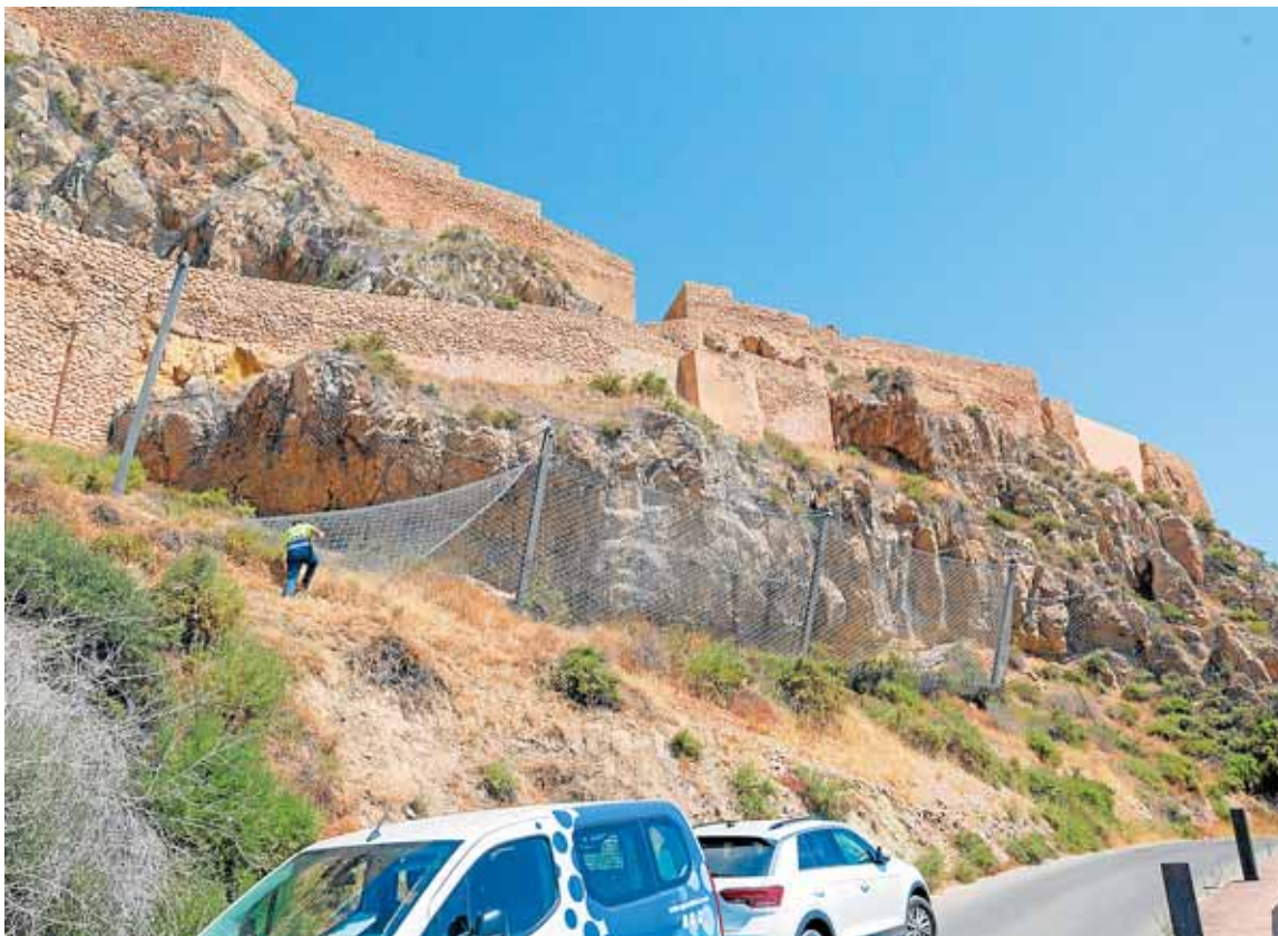
Un operario trabaja en la sustitución de las mallas metálicas en el macizo rocoso de la fortaleza. G. J. M. / AGM
