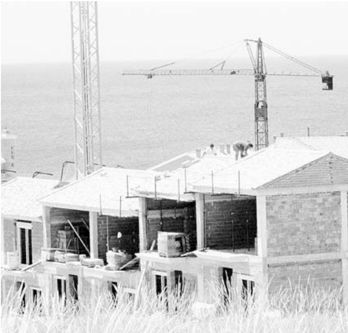
SECTOR EN AUGE. Albañiles trabajando en una promoción junto al mar en el término municipal de Cartagena. La foto es de archivo. / J. M. RODRÍGUEZ / AGM
