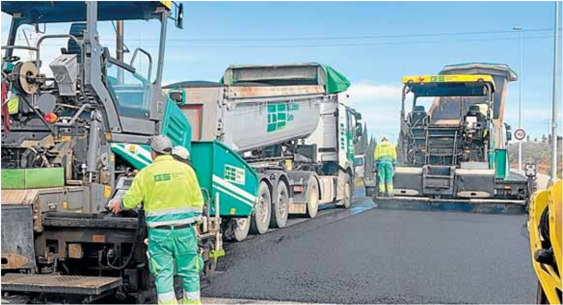
Operarios y máquinas, durante las tareas de asfaltado recién iniciadas por el Ayuntamiento.
