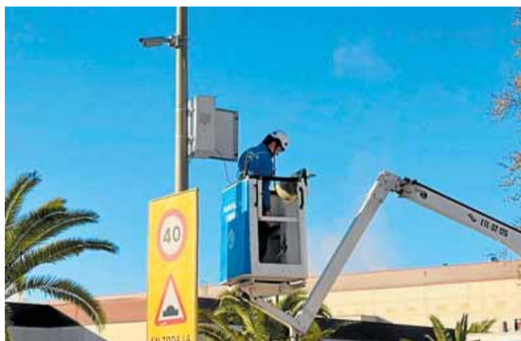
Un operario, montando una de las videocámaras. AYTO.
