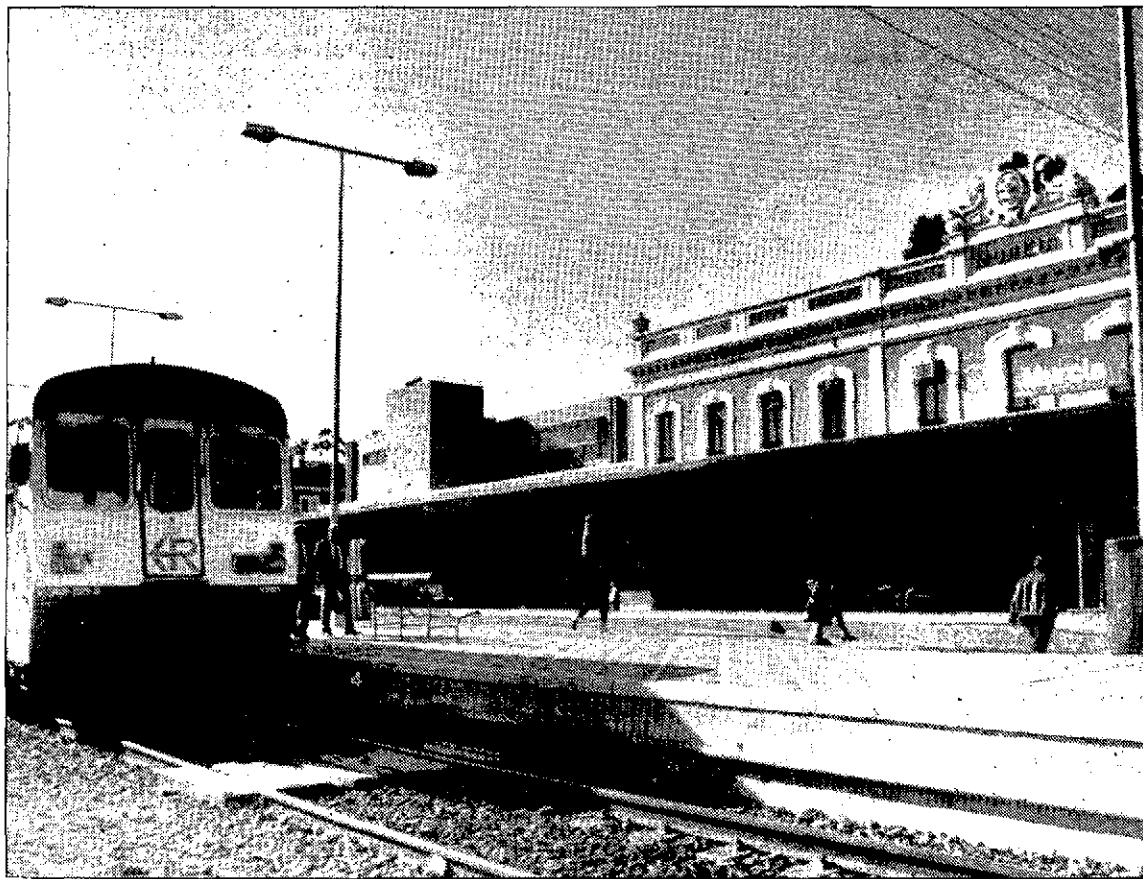
Vías y andenes de la estación de ferrocarril del Carmen. / TITO BERNAL.
