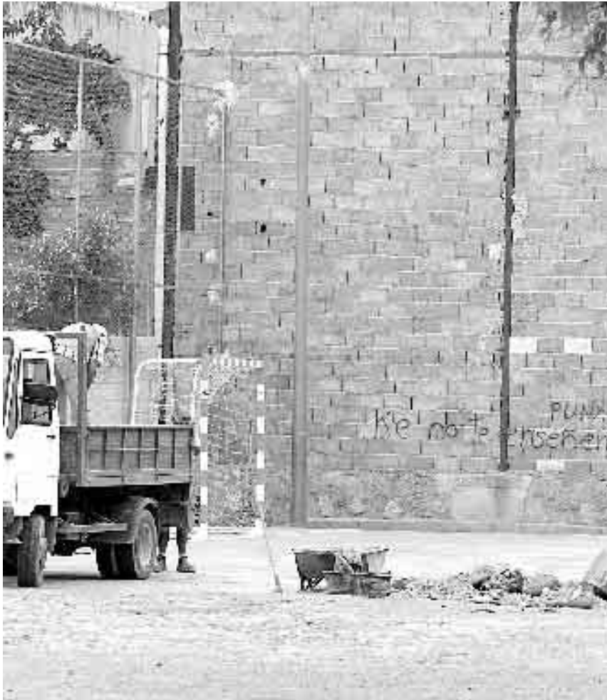
SIN TERMINAR. Trabajos en el colegio de Monteagudo, uno de los que
