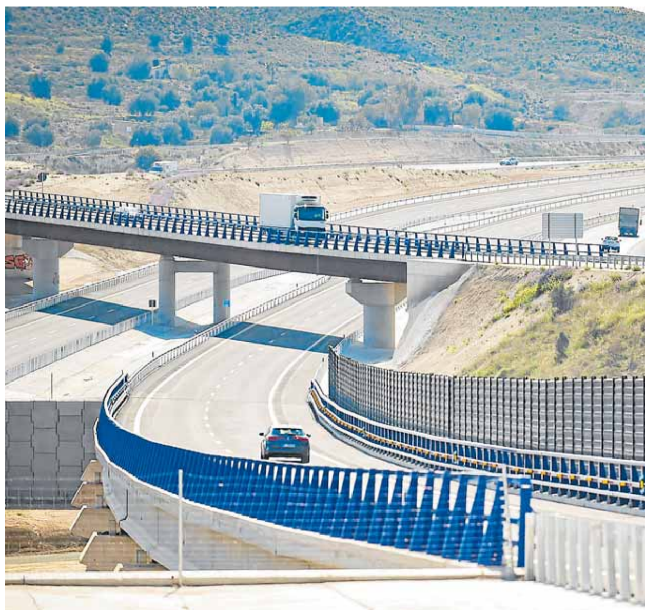
Enlace del Arco Noroeste a la altura de la rambla Salada, en el término de Las Torres de Cotillas. JAVIER CARRIÓN / AGM
