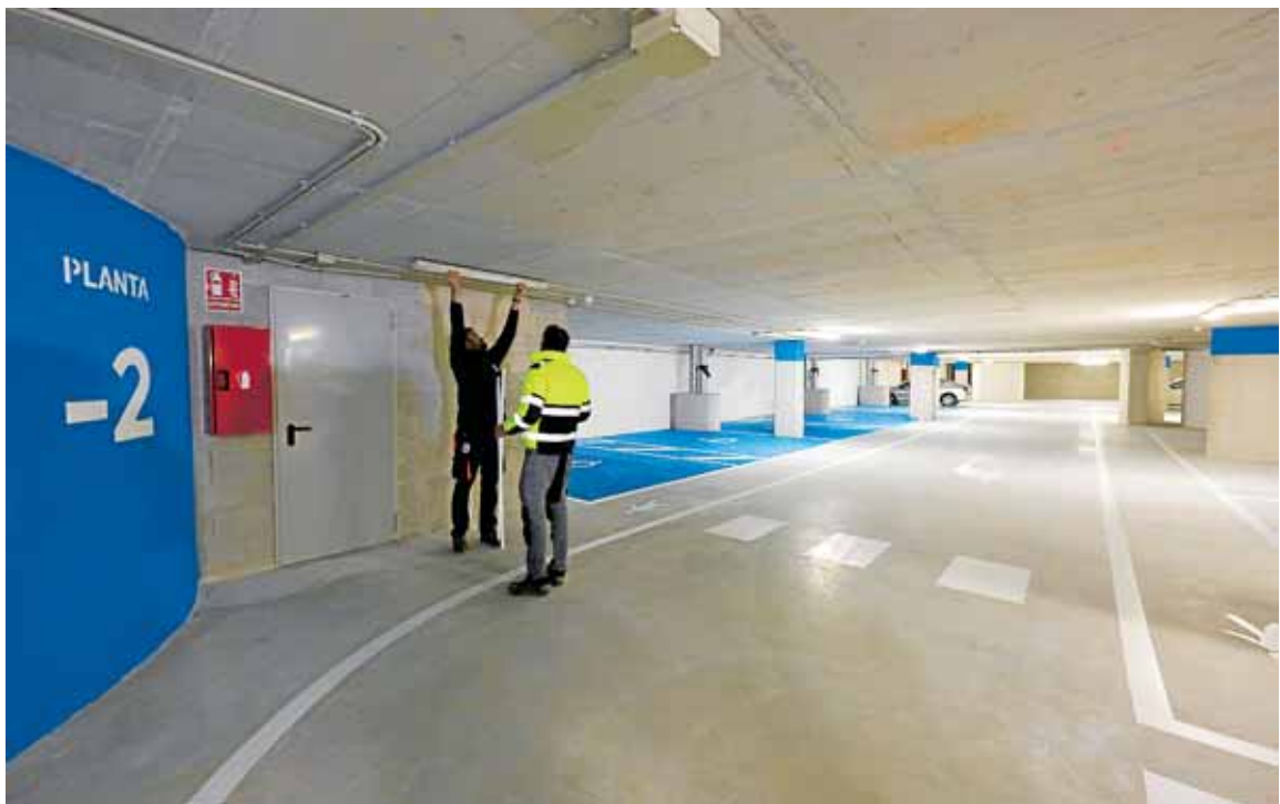
Dos operarios dan los últimos retoques al nuevo parking de Abenarabi. VICENTE VICÉNS / AGM
