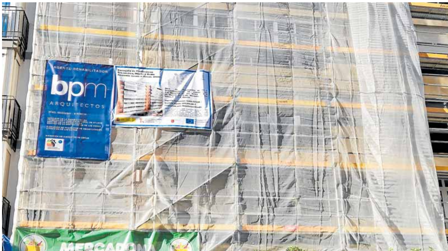
Fachada de uno de los edificios que se están regenerando con fondos 'Next Generation', de la UE, en Marqués de los Vélez. AYTO.
