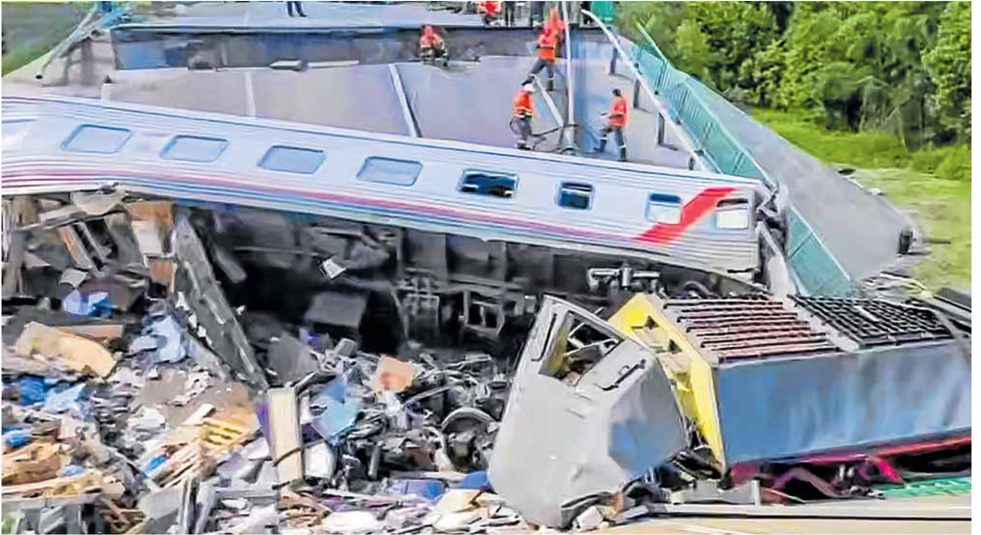
Tren de pasajeros destrozado por el derrumbe de un puente en el distrito de Vygonichsky, en la región rusa de Bryansk. EFE
