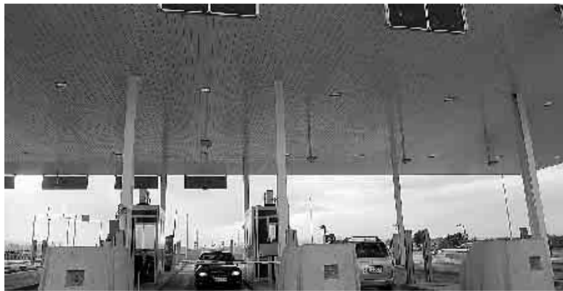
DE PAGO. Un par de vehículos cruzan un peaje el día de la apertura de la autopista. / J.M.R. /AGM
