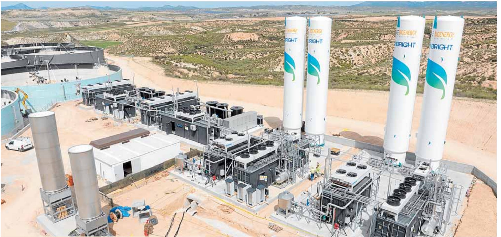
Planta de biometano en construcción en Lorca. Five Bioenergy
