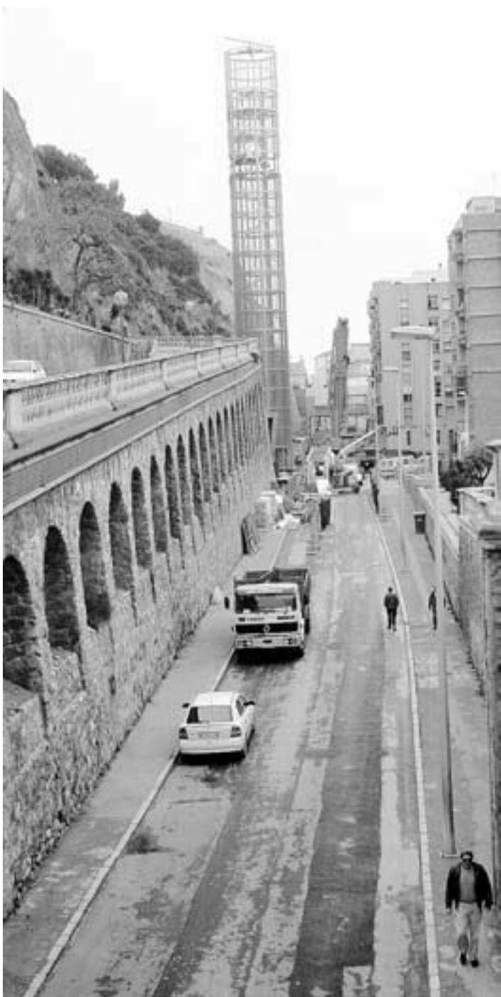
COMO UN FARO. La torre del ascensor, instalada. / A. GIL (AGM)
