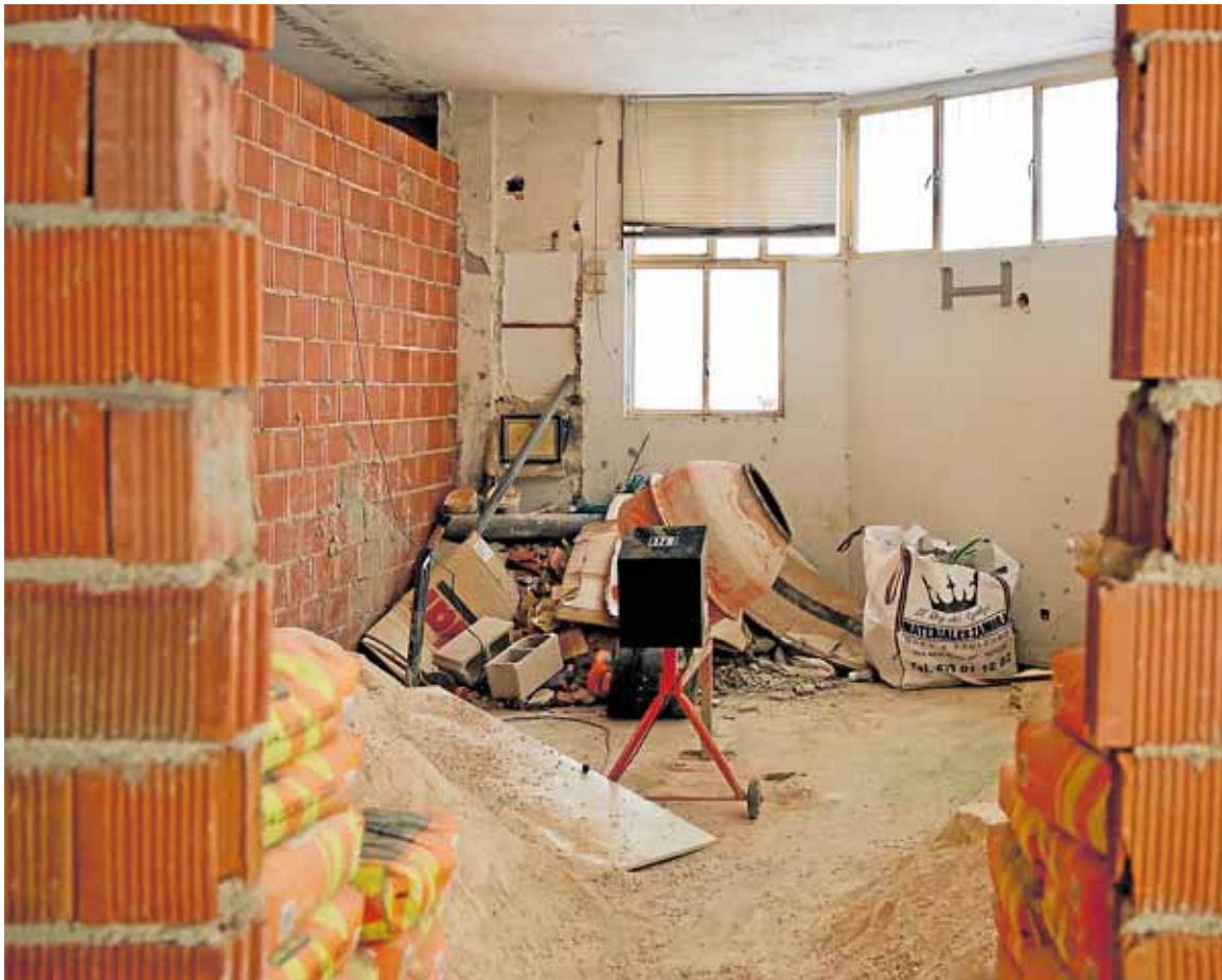
Obras en uno de los bajos comerciales que en 2025 se convirtieron en vivienda en Murcia. NACHO GARCÍA
