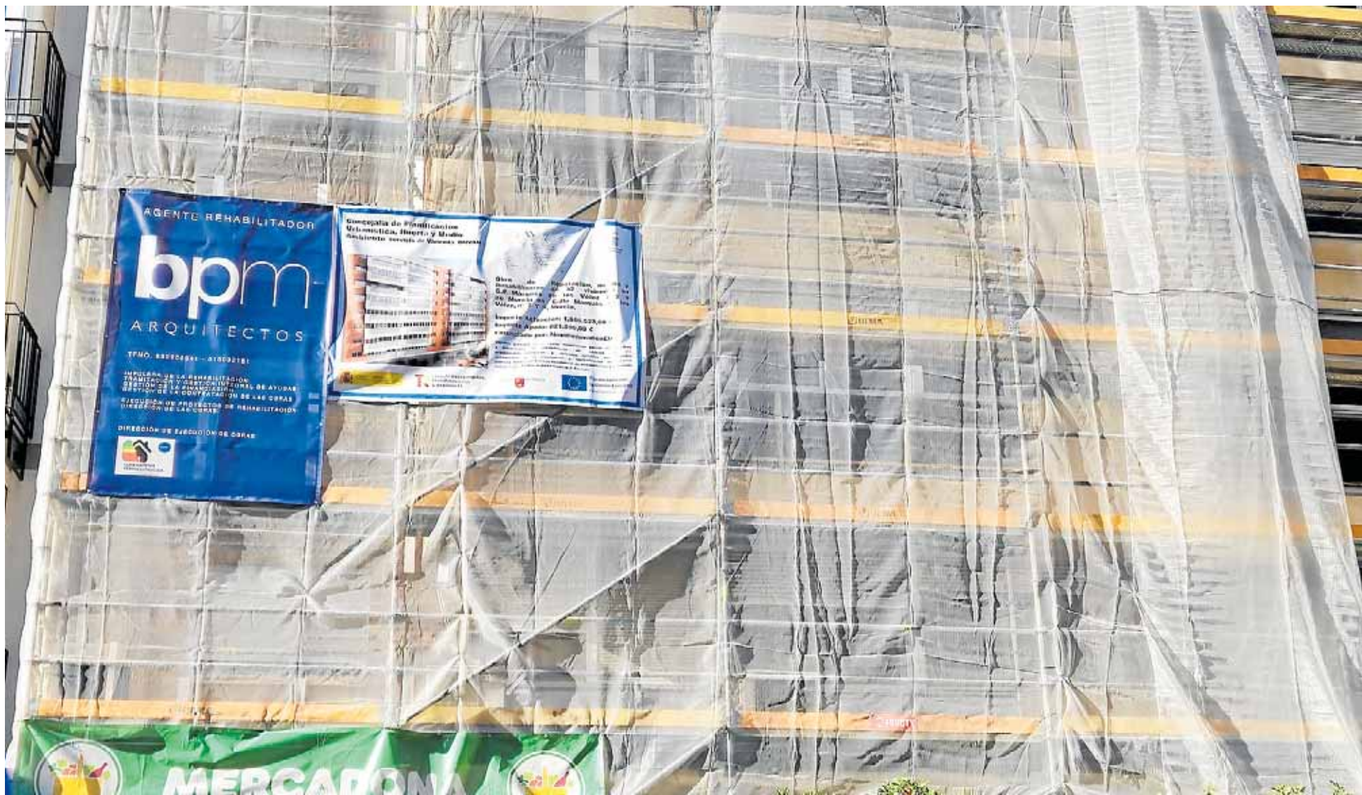
Fachada de uno de los edificios que se están regenerando con fondos 'Next Generation', de la UE, en Marqués de los Vélez. AYTO.
