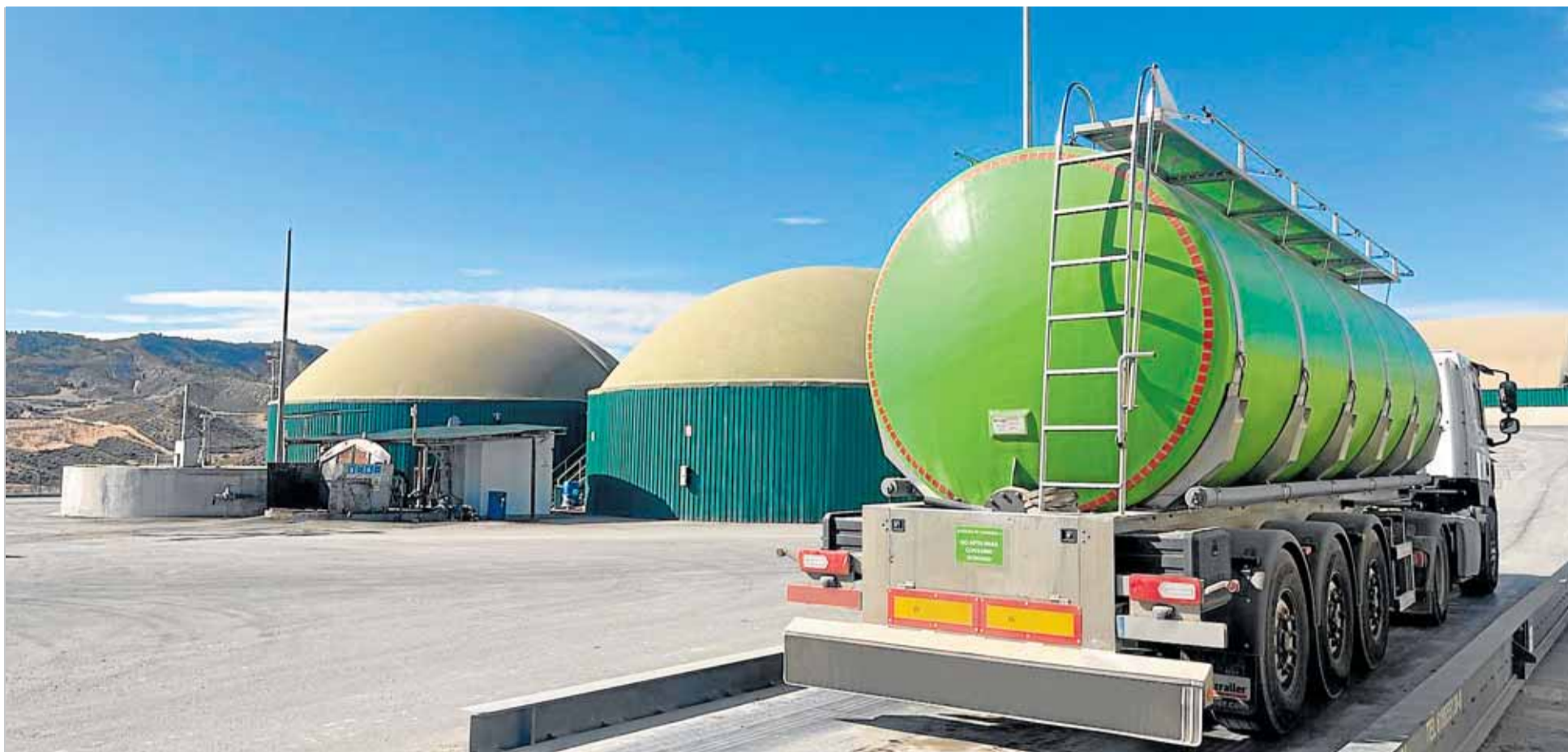
Instalaciones de BioRed Lorca. Redexis
