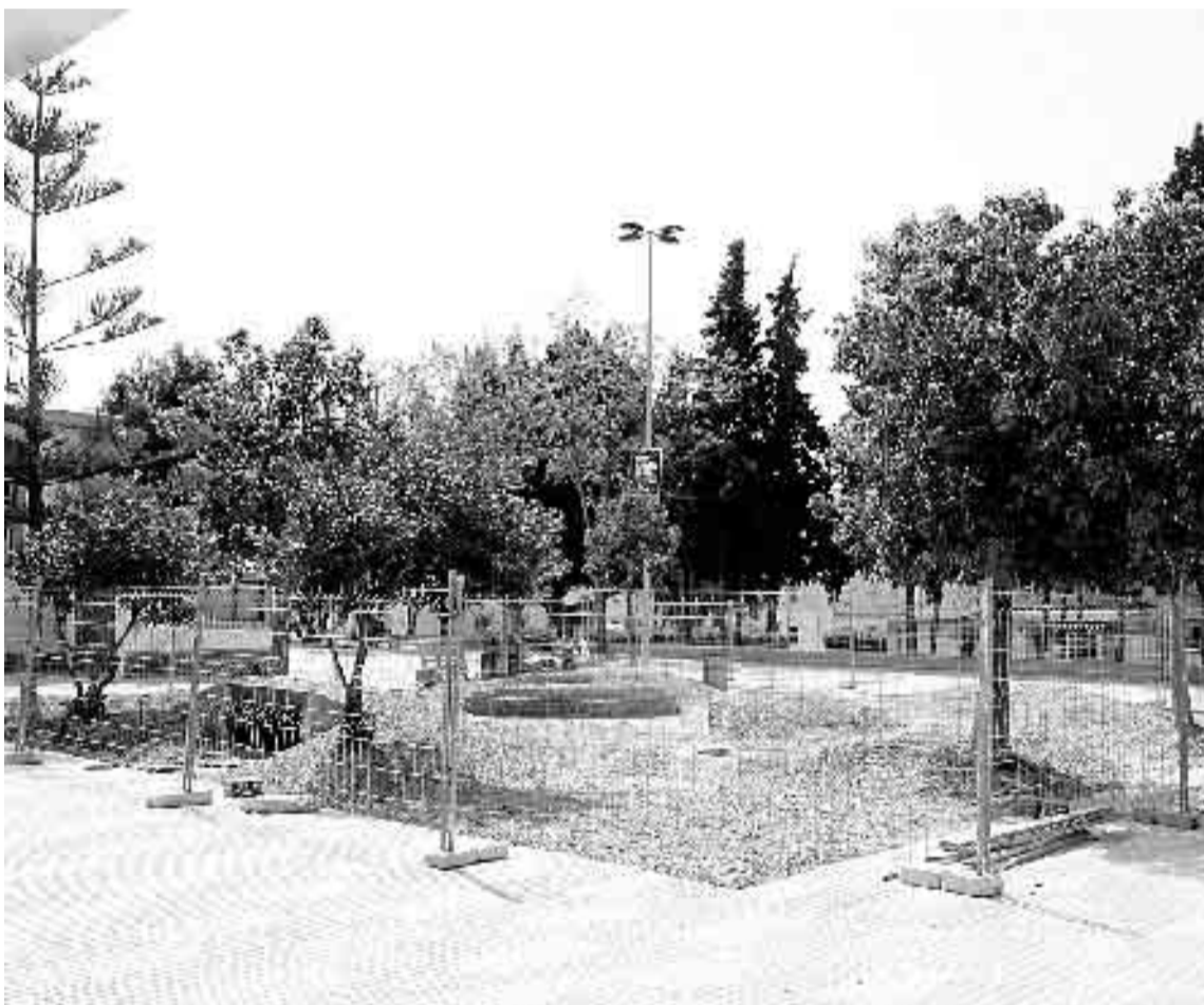
EN CONSTRUCCIÓN. La plaza Cronista Casal, con los montículos donde se ubicará la estructura. / P. S. / AGM
