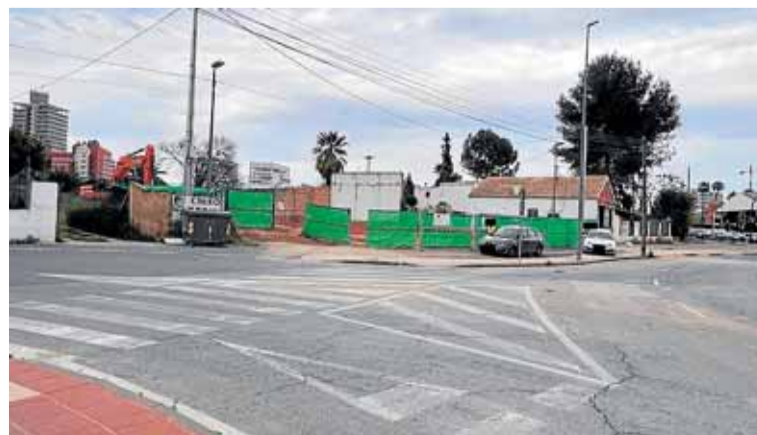
Parcela en obras para la nueva gasolinera. A. V. SENDA DE GRANADA OESTE
